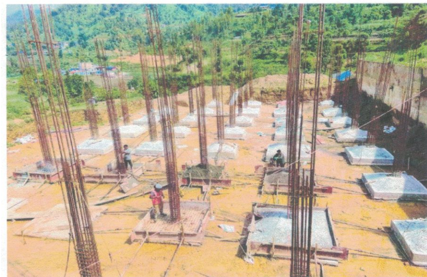
गाउँपालिका भवन निर्माण कार्य
